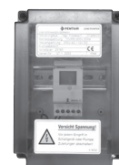
Коммутационное устройство для пробного пуска
